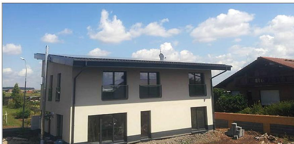
Rysunek 4. Wzorcowy budynek plus energetyczny biogazowni Wolf w Niemczech, gdzie zastosowana pompa ciepła powietrze-woda o wysokiej efektywności jest ważnym elementem wyposażenia (źródło: Neura).
