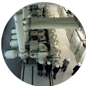
Modernizacja stacji elektroenergetycznej 110 kV
