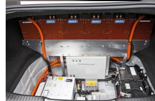
Akumulator LiFePO 4 (8,6kWh) za tylnym siedzeniem Jaguar Limo-Green, Źródło: www.motorvision.de
