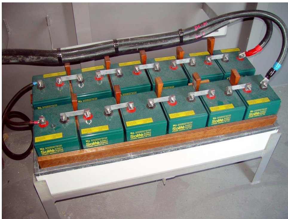
Rysunek 1 — Mały zespół szczelnie zamkniętych ogniw kwasowo-ołowiowych.
