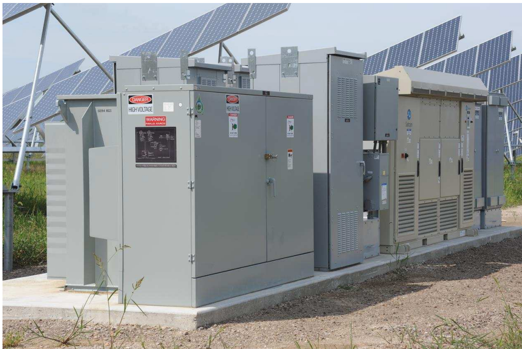
Rysunek 5 — Przetworniki mocy do zastosowań na zewnątrz budynków muszą być odpowiednio chronione przed wpływem czynników atmosferycznych, dlatego umieszcza się je w obudowach.
